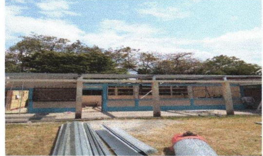
Foto 2: sustitución de lamina por lámina troquelada de aluzinc calibre 26
