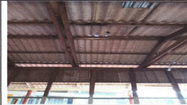
Foto1: Sustitución de estructura de soporte de madera por metal
