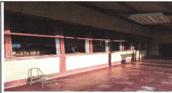
Foto 3: Sutfitucion de ventanas de madera por metal
