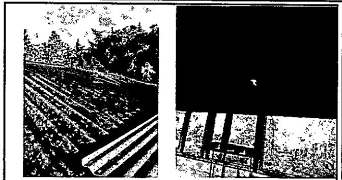
Foto 2: sustitución de lamina por lámina troquelada de aluzinc calibre 26
