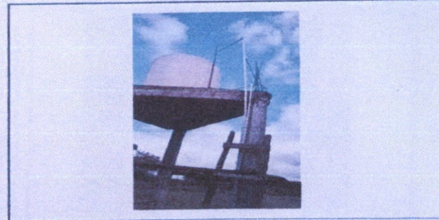
Foto 4: Sustitución de tubería línea principal
