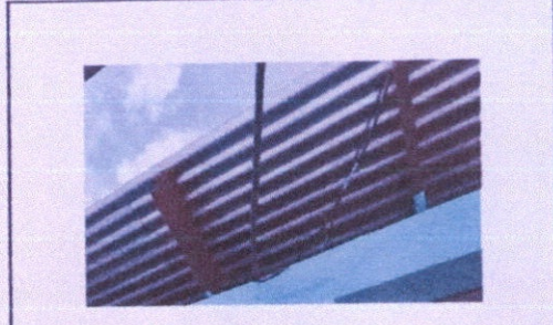
Foto 14: Reparación de cableado electrico
