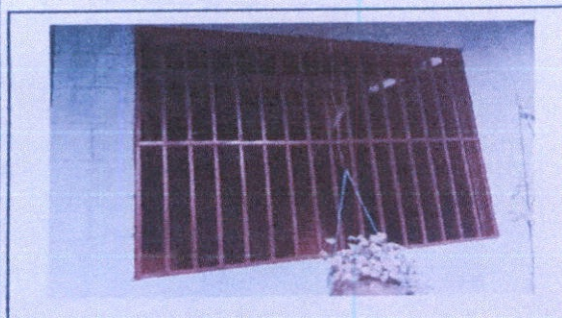
Foto 3: Mantenimiento a balcones de metal
