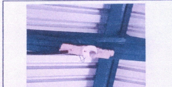
Foto 10: Sustitución de plafoneras
