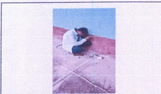
Foto 11: Sustitución de tomacorrientes dobles
