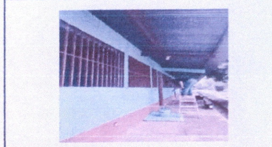
Foto 8: Pintura en muros exteriores e interiores
