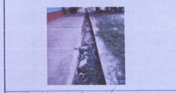
Foto 12: Mantenimiento a reposaderas
