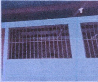
Foto 3: Mantenimiento a balcones de metal
