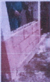
Foto 5: Repello en muro y pared de poso
