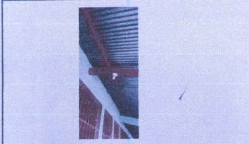
Foto 9: Sustitución de focos ahorradores
