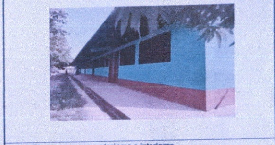
Foto 8: Pintura en muros exteriores e interiores
