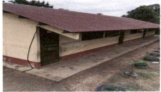
Foto 2: sustitucion de lámina por lamina troquelada de aluzinc calibre 26
