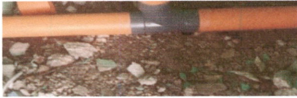
SUSTITUCIÓN DE TUBERIA LINEA PRINCIPAL AGUAS NEGRAS
