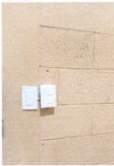
SUSTITUCION DE INTERRUPTORES SIMPLES
