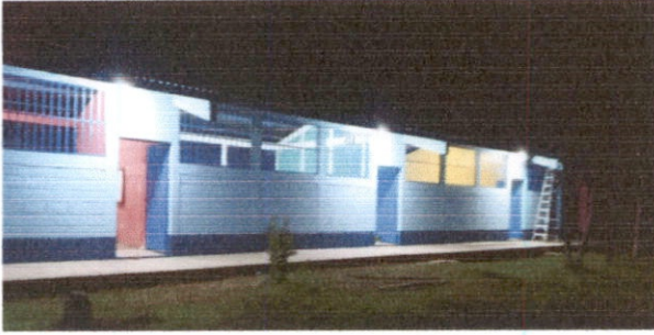
MANTENIMIENTO ESTRUCTURA PUERTAS DE METAL
