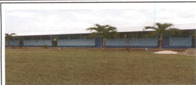
SUSTITUCIÓN DE LAMINA POR LAMINA TROQUELADA ALUZINC CALIBRE 26
