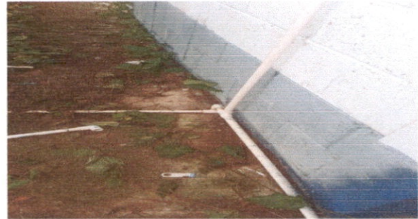
SUSTITUCIÓN DE TUBERIA PRINCIPAL AGUA POTABLE
