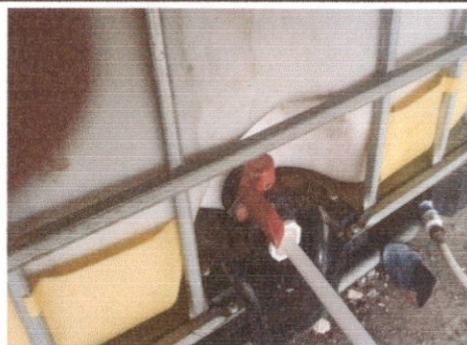
SUSTITUCIÓN DE DEPOSITO DE AGUA
