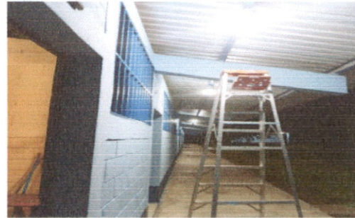
SUSTITUCIÓN DE PLAFONERAS
