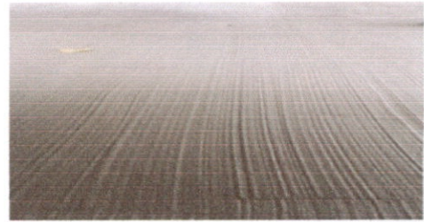
SUSTITUCIÓN DE PISO DE TORTA DE CONCRETO
