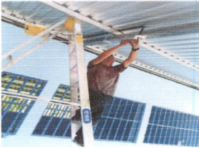
SUSTITUCIÓN DE FOCOS AHORRADORES
