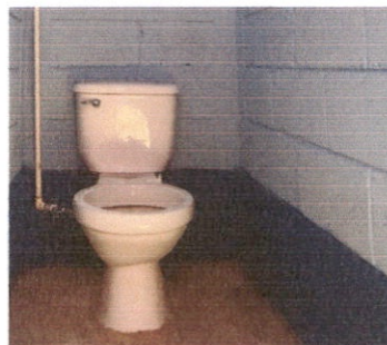
SUSTITUCIÓN DE ACCESORIOS INODORO
