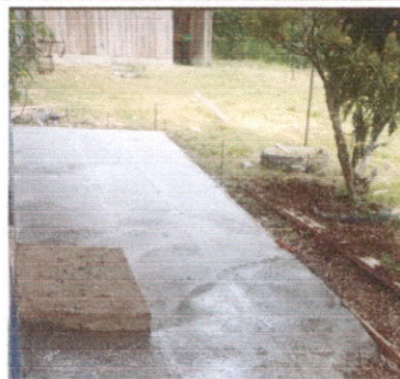
SUSTITUCIÓN DE TORTA DE CEMENTO
