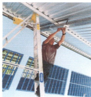
SUSTITUCIÓN DE PLAFONERAS
