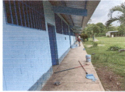
PINTURA EN EXTERIOR
