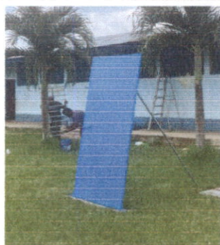
MANTENIMIENTO ESTRUCTURA PUERTAS DE METAL
