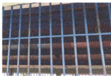
MANTENIMIENTO A BALCONES DE METAL
