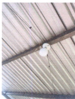
SUSTITUCIÓN DE FOCOS AHORRADORES
