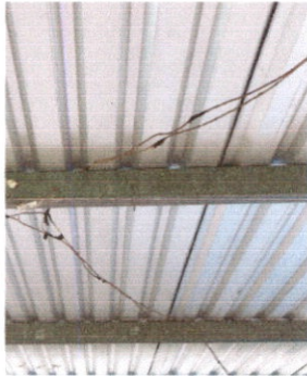
SUSTITUCIÓN DE DUCTO ELECTRICO + ACCESORIOS
