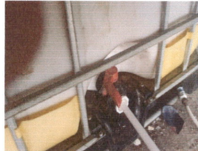
SUSTITUCIÓN DE DEPOSITO DE AGUA
