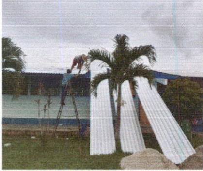
SUSTITUCIÓN DE LAMINA POR LAMINA TROQUELADA ALUZINC CALIBRE 26
