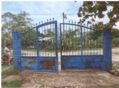
MANTENIMIENTO A PORTON DE METAL
