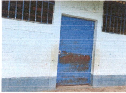
MANTENIMIENTO ESTRUCTURA PUERTAS DE METAL
