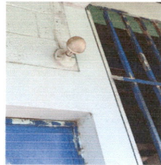
SUSTITUCIÓN DE PLAFONERAS
