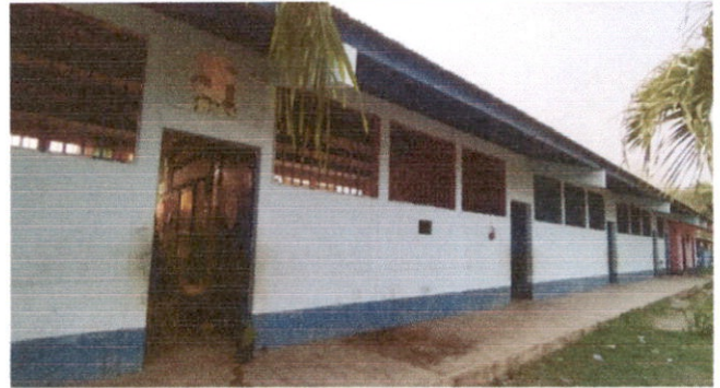
PINTURA EN EXTERIOR
