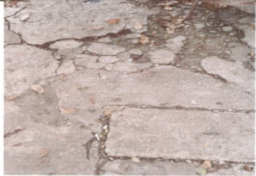
SUSTITUCIÓN DE PISO DE TORTA DE CONCRETO
