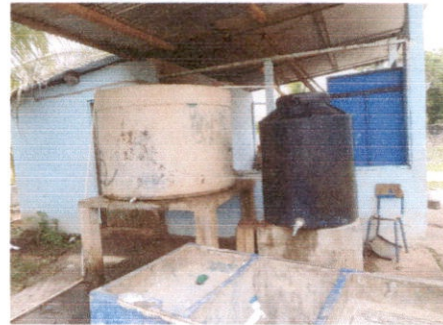
SUSTITUCIÓN DE DEPOSITO DE AGUA
