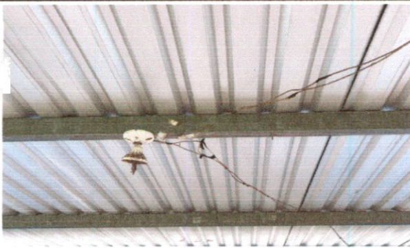
SUSTITUCIÓN DE DUCTO ELECTRICO + ACCESORIOS
