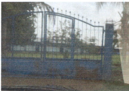
MANTENIMIENTO A PORTON DE METAL
