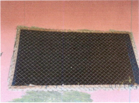
SUSTITUCIÓN DE BALCON DE METAL
