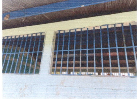
MANTENIMIENTO A BALCONES DE METAL
