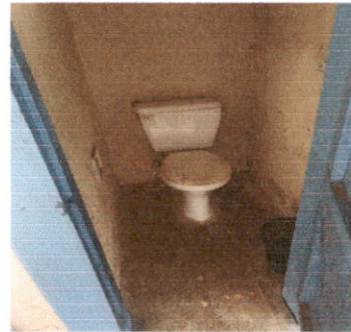
SUSTITUCION ACCESORIOS INODORO
