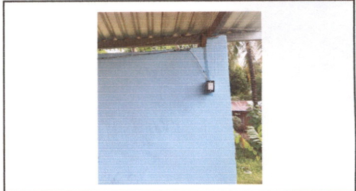
SUSTITUCIÓN DE TOMACORRIENTE DOBLE
