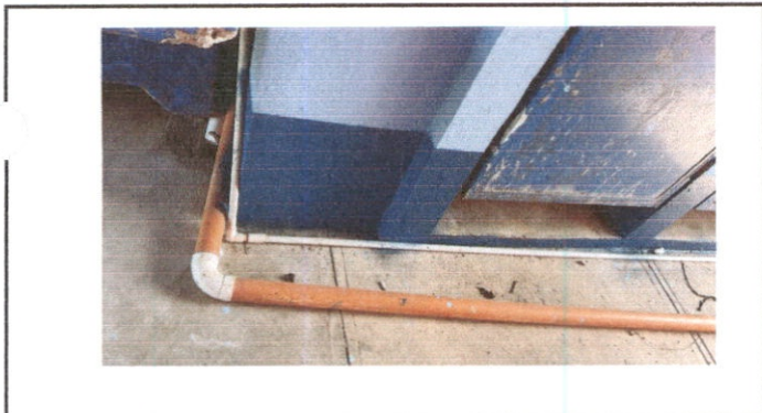
SUSTITUCIÓN DE TUBERIA LINEA PRINCIPAL AGUAS NEGRAS
