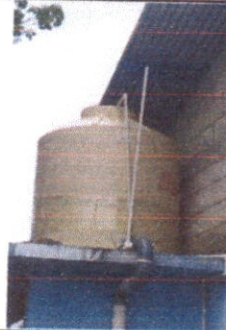
Foto 8: sustitución de depósito de agua
