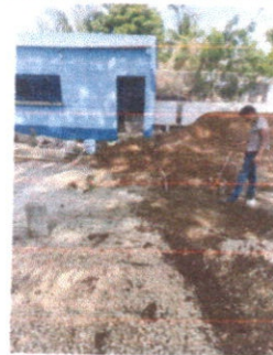
Foto 10: sustitución de tubería lineal principal
