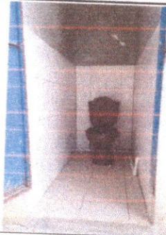
Foto 7: sustitución de inodoros (tasas)
