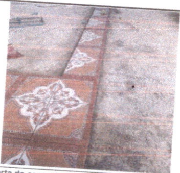
Foto 5: sustitución; torta de cemento de cocina y cerámica
