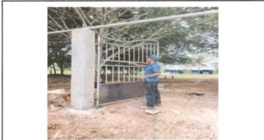
Foto7 :Sustitución de porton de metal de metal
