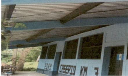
Foto 3: Sustitución de elementos de fijacion
