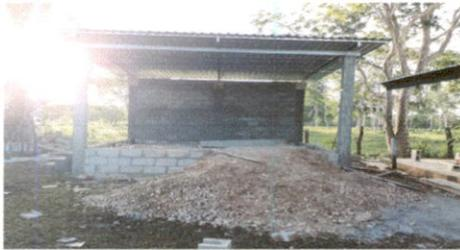
Foto 5: Sustitución de lamina, por lamina troquelada aluzinc calibre 26 escenario
