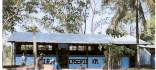
Foto 2: Sustitución de capote de lámina troquelada
