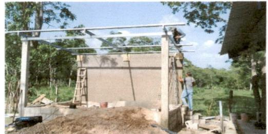
Foto 4: Sustitución de estructura de soporte de madera, por metal modulo escenario
