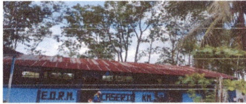
Foto 2: Sustitución de capote de lamina troquelada
