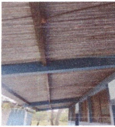
Foto 3: Sustitución de elementos de fijación
