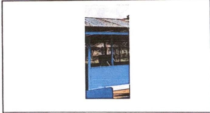
Foto 4: Sustitucion de balcon de malla metalica
