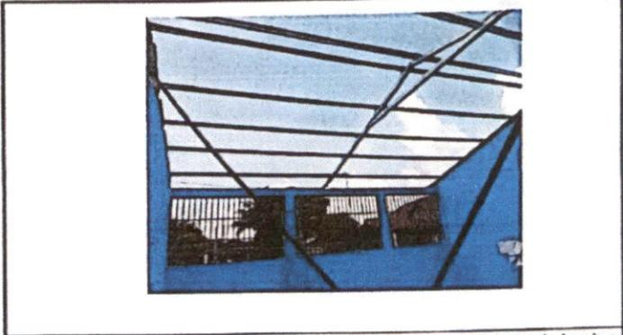
Foto 2: sustitucion de estructura de soporte de metal y cubierta de lamina
