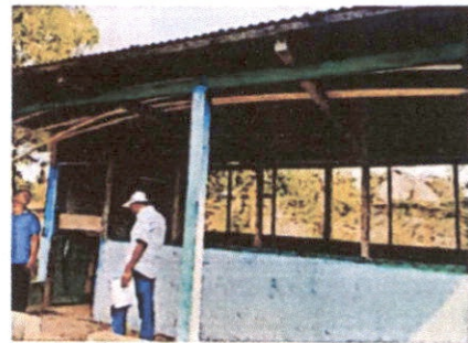
Foto 4: Sustitucion de balcon de malla metalica
