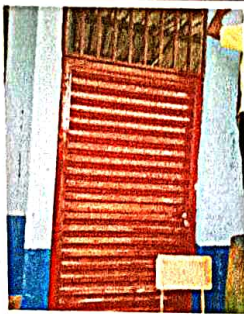
Foto 3: Mantenimiento a estructura de puertas de metal
