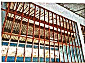
Foto 5: Mantenimiento a balcones de Metal
