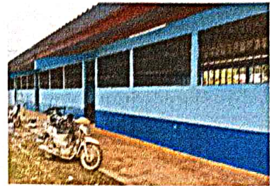
Foto 2: pintura en muros interior y exterior
