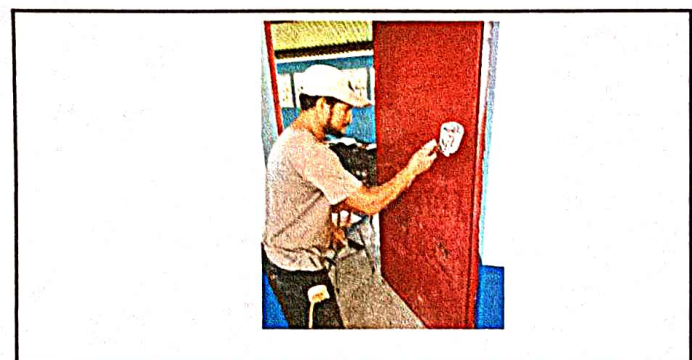
Foto 3: Mantenimiento a estructura de puertas de metal
