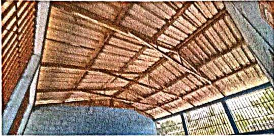
Foto1: Sustrucción de estructura de soporte de madera por metal y sustitución de lamina troquelada
