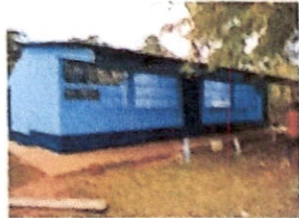
Foto 1: Sustitución de lamina troquelada
