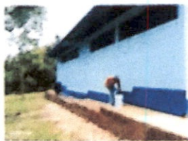
Foto 5: Pintura en muros interior y exterior
