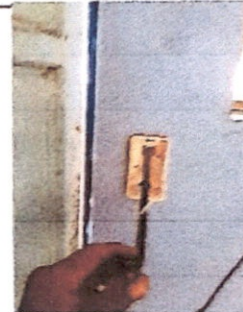
Foto 4: Reparación de sistema eléctrico (cable principal, plafoneras, focos, tomacorrientes, interruptores)
