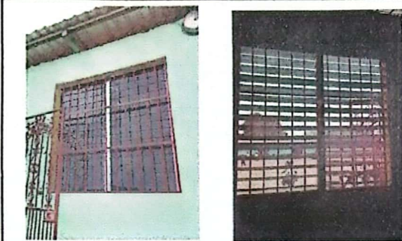
Foto 13: Sustitución de Ventanas de madera por metal mas vidrio
