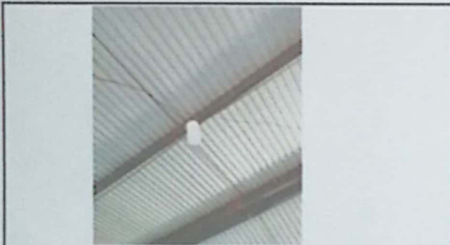
Foto 9: Sustitución de focos ahorradores
