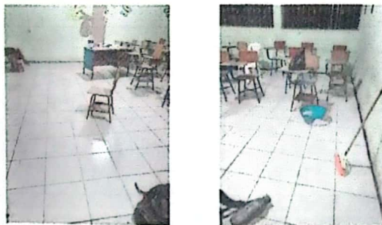
Foto 5: sustición de piso de cemento líquido por piso ceramico
