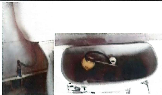
Foto 6: Sustitución de accesorio de Inodoro
