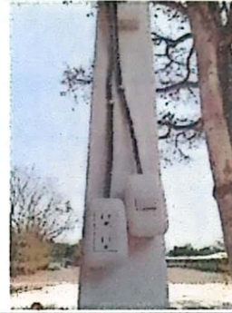
Foto 14: Sustitución de interruptores simples
