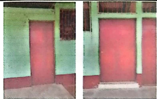
Foto 4: Sustitución de puerta de metal
