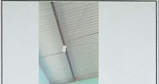
Foto 8: Sustitución de plafonera
