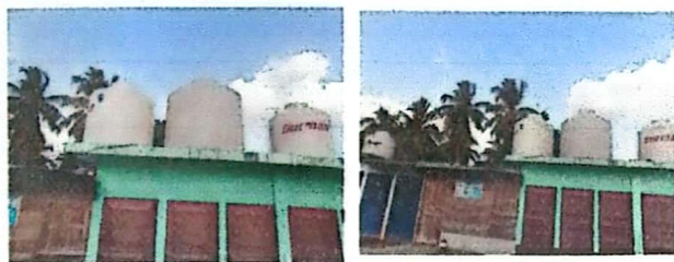
Foto 3: Sustitucion de deposito de Agua de 1700 lt
