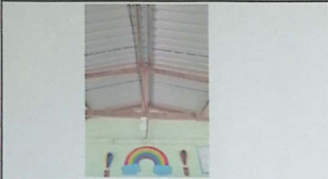
Foto 7: Reparación de cableado eléctrico
