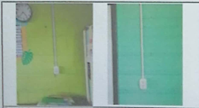
Foto 11: Sustitución de tomacorriente doble
