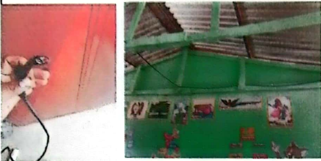
Foto 7: Reparación de cableado eléctrico
