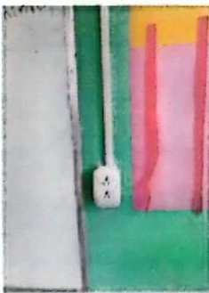
Foto 11: Sustitución de tomacorriente doble
