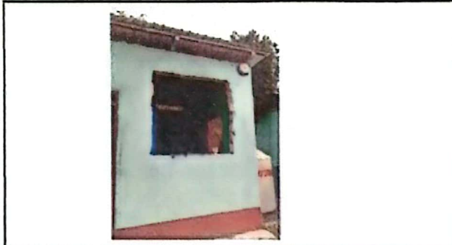
Foto 13: Sustrucción de Ventanas de madera por metal mas vidrio
