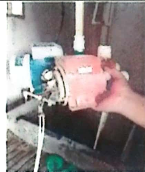
Foto 10: Sustitución de bomba de agua
