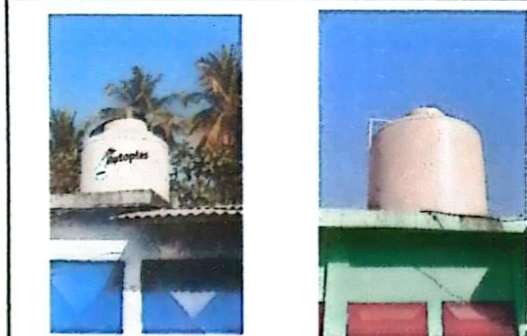
Foto 3: Sustitución de deposito de Agua de 1700 lt
