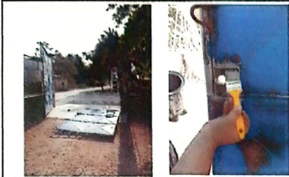
Foto1: Mantenimiento a estructura de porton de metal
