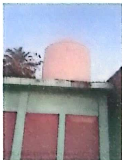
Foto 3: Sustitucion de deposito de Agua de 1700 It
