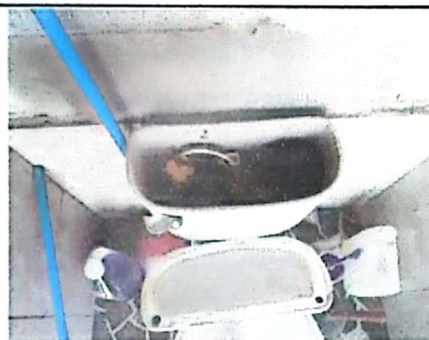
Foto 6: Sustitución de accesorio de inodoro
