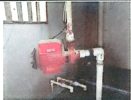
Foto 10: Sustitución de bomba de agua
