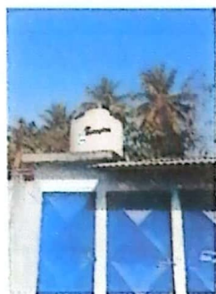
Foto 3: Sustitucion de deposito de Agua de 1700 It
