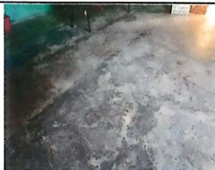
Foto 2: Sustitución de Piso ceramico
