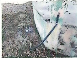
Foto 7: Reparación de cableado eléctrico
