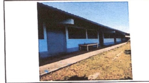
Foto 6: Pintura en muros exteriores e interiores
