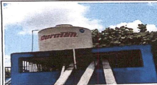
Foto 9: Sustitución de depósito de agua de 1700 litros
