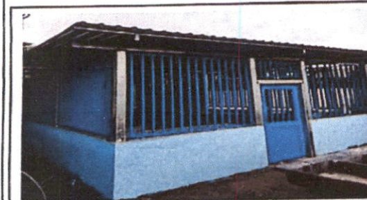
Foto 5: Sustitución de balcones de metal
