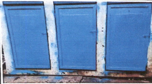
Foto 7: Sustitución de puerta de baño
