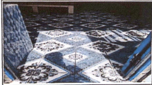
Foto 8: Sustitución de piso cerámico
