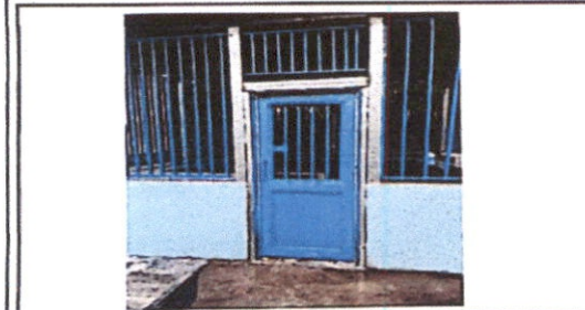
Foto 3: Sustitución de puerta
