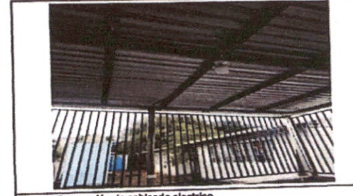
Foto 12: Reparación de cableado eléctrico
