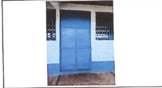
Foto 4: Mantenimiento a puertas
