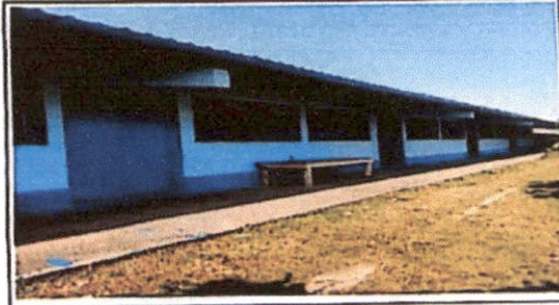
Foto 6: Pintura en muros exteriores e interiores
