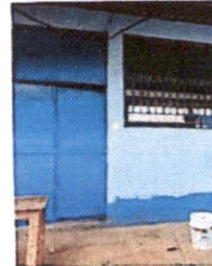
Foto 4: Mantenimiento a puertas
