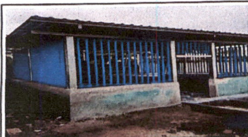
Foto 5: Sustitución de balcones de metal
