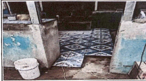
Foto 8: Sustrucción de piso cerámico
