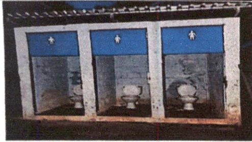
Foto 7: Sustrucción de puertas de baño
