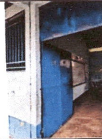
Foto 4: Mantenimiento a puertas
