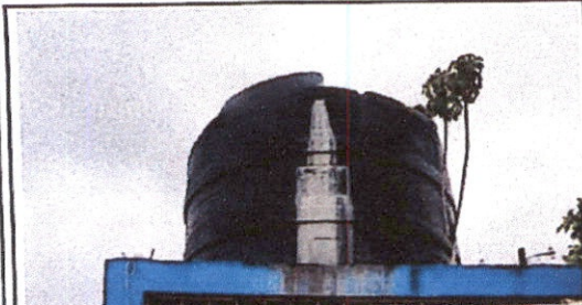
Foto 9: Sustitución de deposito de agua de 1700 litros
