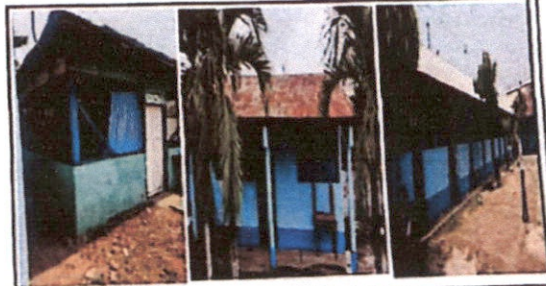
Foto 6: Pintura en muros exteriores e interiores
