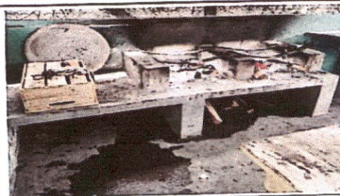
Foto 9: Reparación de estufa rural
