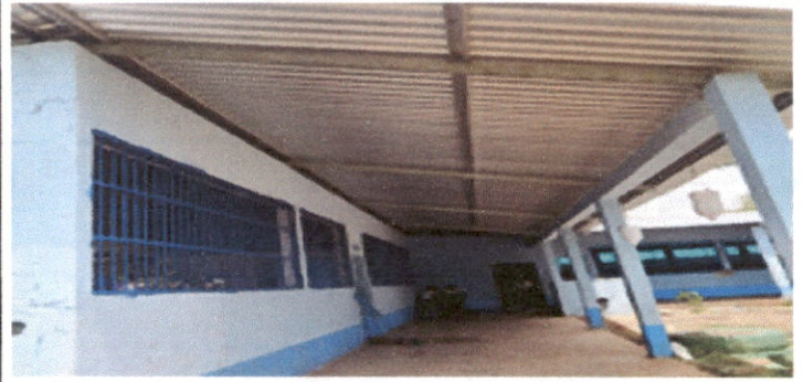
Foto 2:Sustitución de estructura de soporte de madera, por metal
