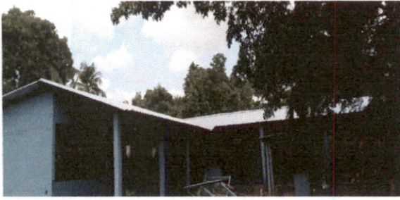
Foto1:Sustitución de lamina, por lamina troquelada aluzinc calibre 26 modulo de aulas
