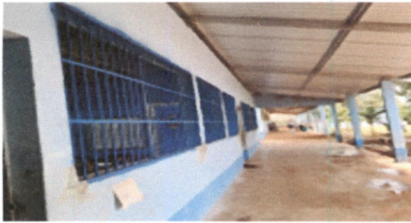
Foto 3: Sustitución de balcones de metal
