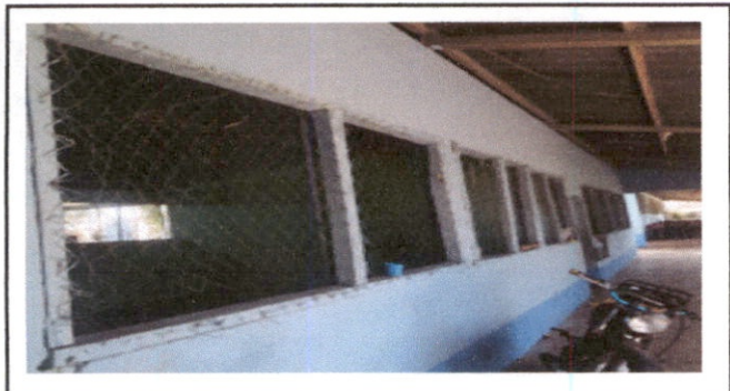
Foto 3: Sustitución de valcones de metal
