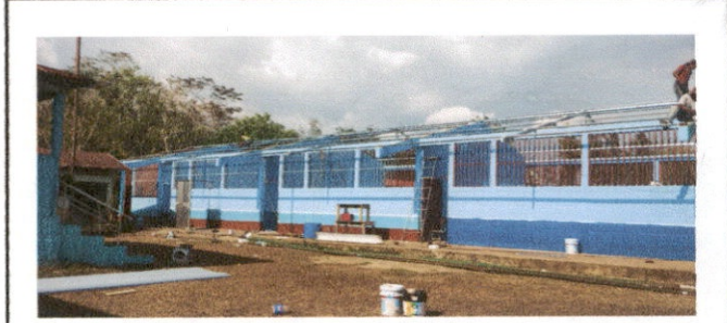
Foto 2:Sustitución de estructura de soporte de metal por metal
