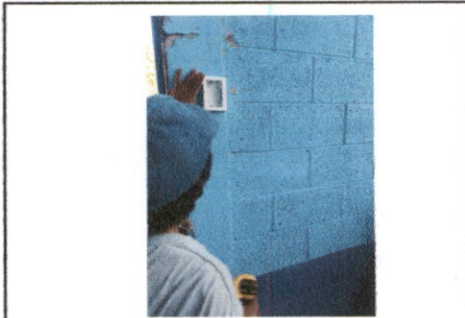
Foto 13: Sustitución de tomacorriente doble
