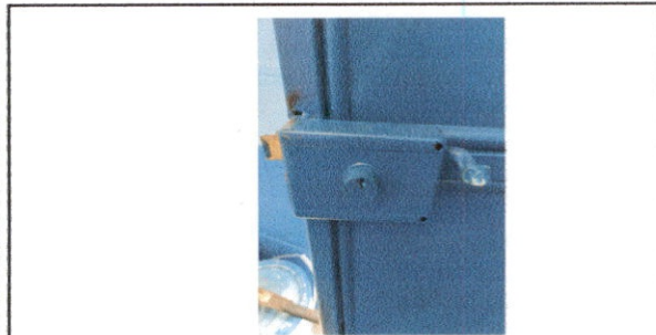
Foto 5: Sustitución de chapa
