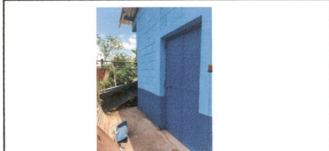
Foto 4: Sustitución de puerta de metal
