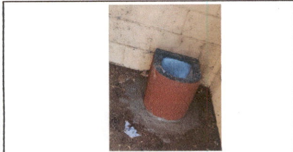
Foto 3:sustitución de inodoro
