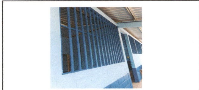
Foto 6: Mantenimiento a balcones de metal
