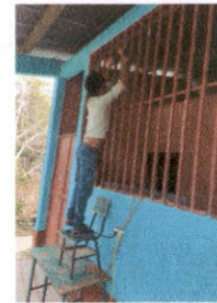
Foto 6: Mantenimiento a balcones de metal
