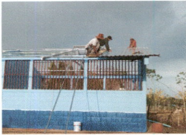
Foto1: Sustitución de lamina, por lamina troquelada aluzinc calibre 26 modulo de aulas
