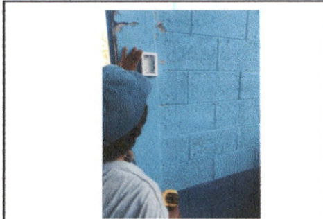
Foto13: Sustitución de tomacorriente doble
