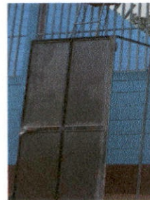
Foto 4: Sustitución de puerta de metal
