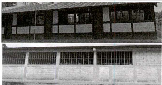
Foto 03. Mantenimiento de balcones de metal
