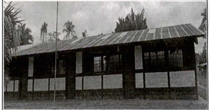
Foto 02. Instalación de lámina troquelada Aluzinc ✓
