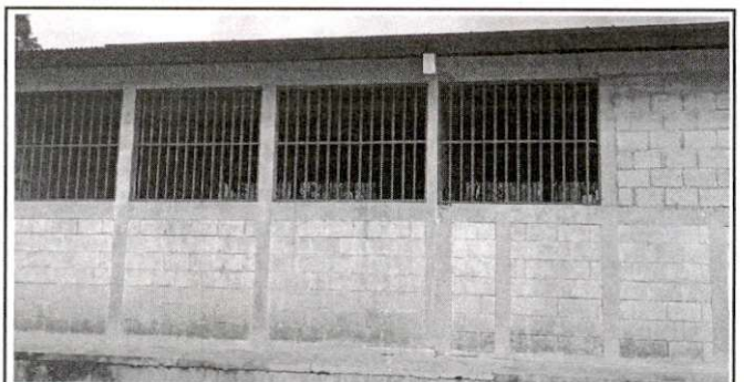
Foto 06. Pintura en muros exteriores
