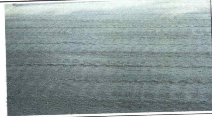
SUSTITUCIÓN DE TORTA DE CONCRETO
