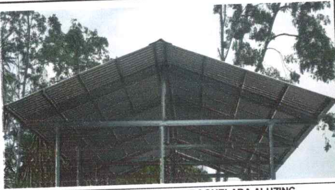
SUSTITUCIÓN DE LAMINA, POR LAMINA TROQUELADA ALUZINC CALIBRE 26
