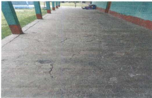
Foto 5: Sustitución de piso de torta de concreto
