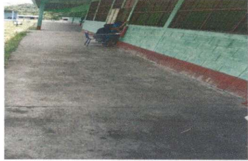
Foto 2: Sustitución de piso de cemento líquido
