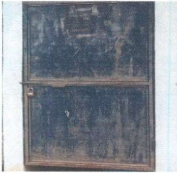
Foto 3: Sustitución de puertas- Fabricación e instalación
