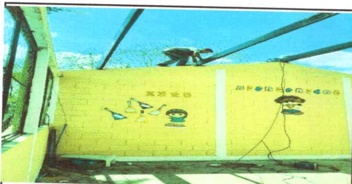
Foto 5: CAMBIO DE CUBIERTA DE LAMINA
