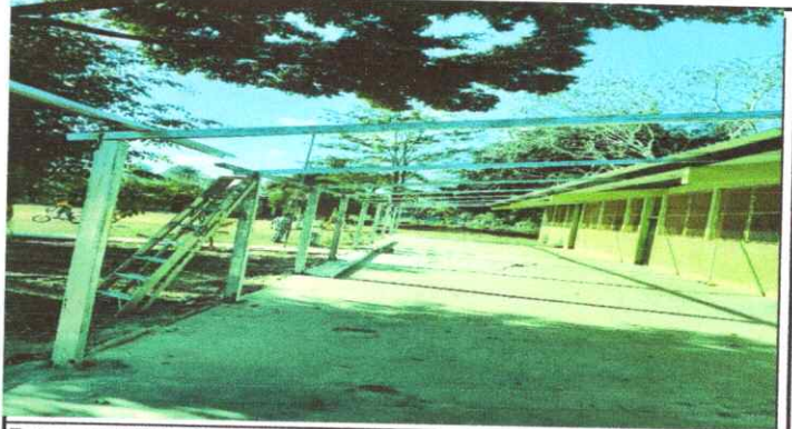
Foto 2: CAMBIO DE ESTRUCTURA Y CUBIERTA DE LAMINA
