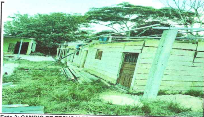
Foto 3: CAMBIO DE TECHO Y ESTRUCTURA
