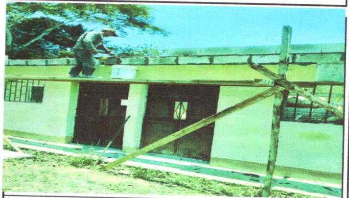
CAMBIO DE CUBIERTA DE LAM
