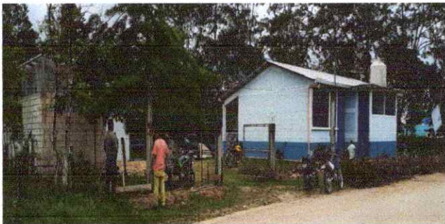
Foto 5: Reparación de de tubo HG y malla galvanizada
