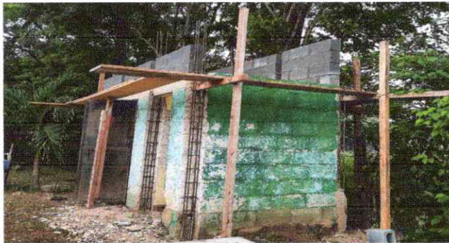
Foto 3: Reparación de muro de contención
