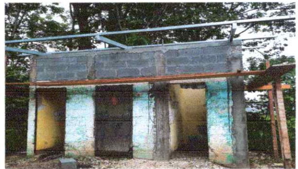
Foto 4: Sustitución de estructura de soporte demetal por metal
