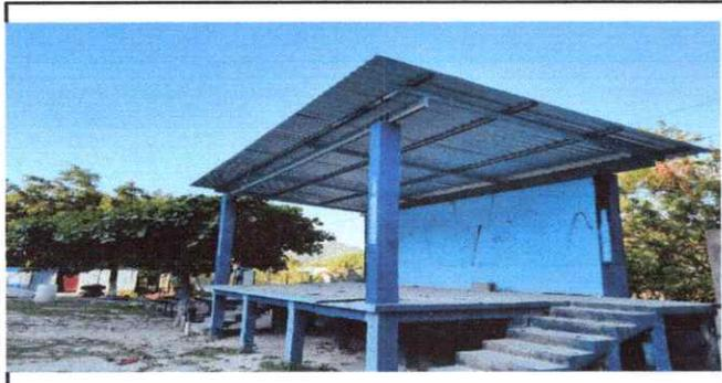
Foto 3: Sustitución de lámina, por lámina troquelada, sustitución de estructura de soporte de madera por metal
