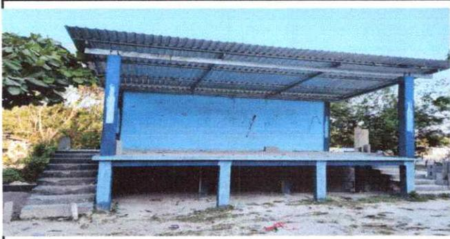
Foto1: Sustitución de lámina, por lámina troquelada, sustitución de estructura de soporte de madera por metal
