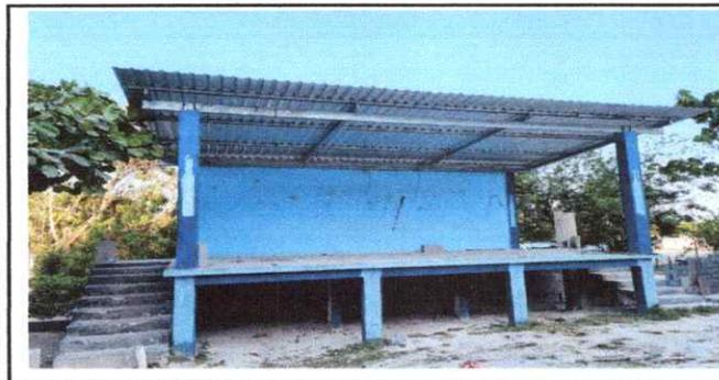
Foto 5: Sustitución de lámina, por lámina troquelada, sustitución de estructura de soporte de madera por metal
