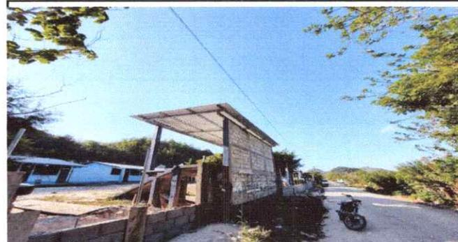
Foto 4: Sustitución de lámina, por lámina troquelada, sustitución de estructura de soporte de madera por metal
