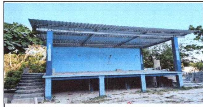
Foto 6: Sustitución de lámina, por lámina troquelada, sustitución de estructura de soporte de madera por metal
