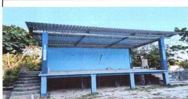
Foto 2: Sustitución de lámina, por lámina troquelada, sustitución de estructura de soporte de madera por metal
