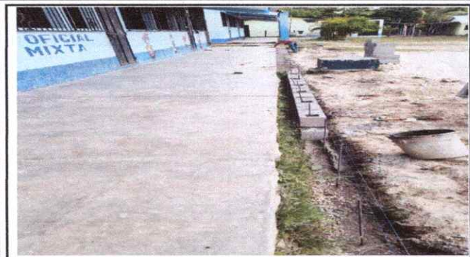
Foto 1: Restructuración de banqueta
