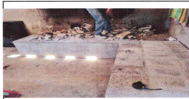
Foto 6: Reparación de estufa rural completa
