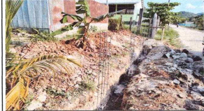
Foto 1: Fundición de columnas
