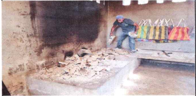
Foto 2: Reparación de estufa rural completa
