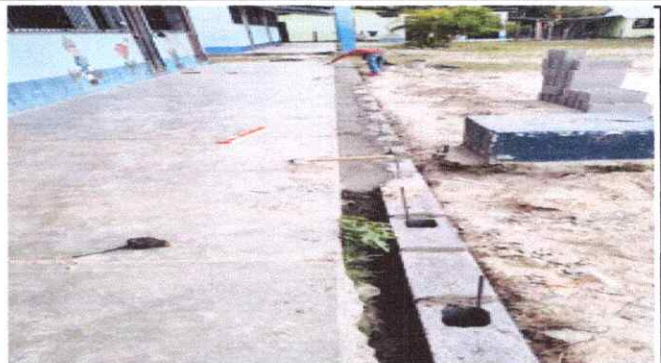
Foto 2: Restructuración de banqueta
