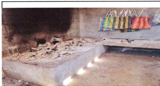
Foto 5: Reparación de estufa rural completa
