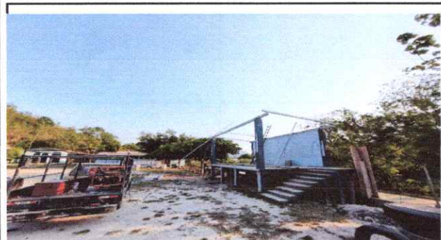
Foto 5: Instalación es estructura portante de metal
