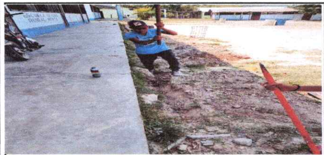
Foto 3: Sanjeo, restructuración banqueta
