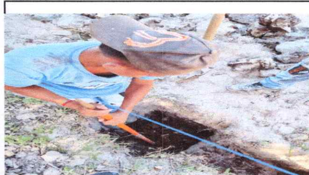
Foto 4: sanjeo de columnas
