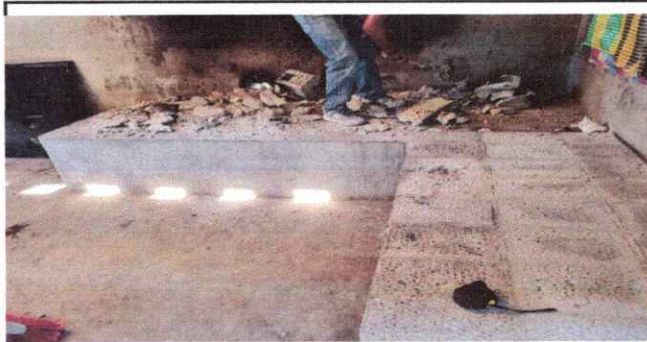
Foto 3: Reparación de estufa rural completa
