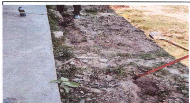
Foto 4: Sanjeo, restructuración banqueta
