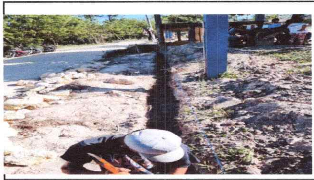
Foto 2: Sanjeo para levantar cemento
