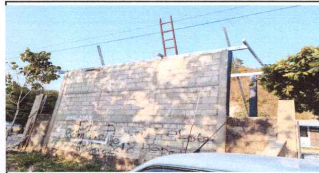
Foto 4: Instalación es estructura portante de metal
