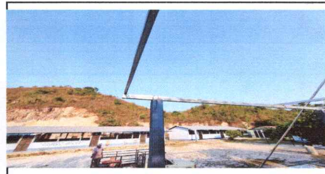
Foto 6: Instalación es estructura portante de metal
