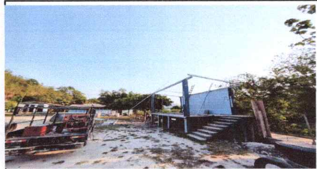
Foto 2: Instalación es estructura portante de metal
