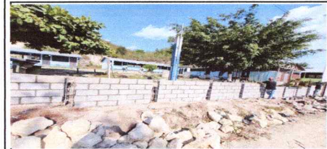
Foto 5: Levantado de hiladas de block
