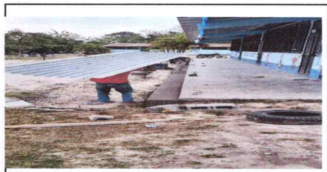
Foto 6: Fundición y repello de banqueta
