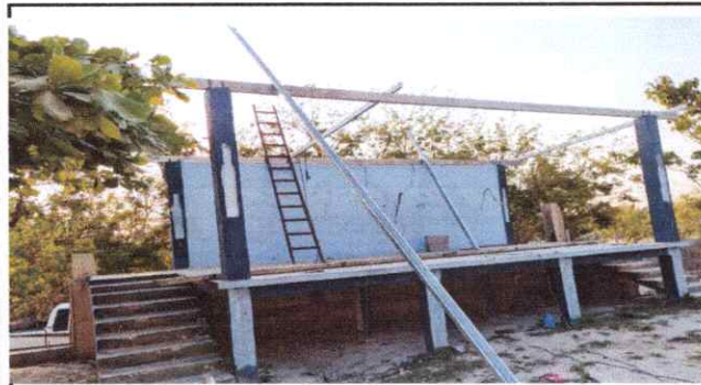
Foto 3: Instalación es estructura portante de metal
