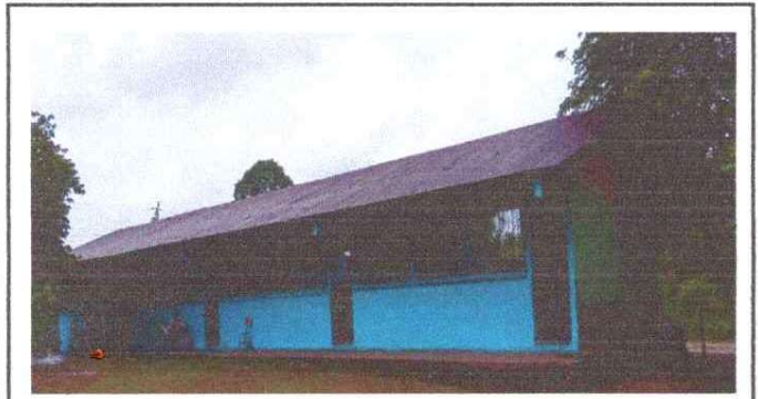
Foto 7: Instalación de lámina troquelada Aluzin calibre 26. ✓
