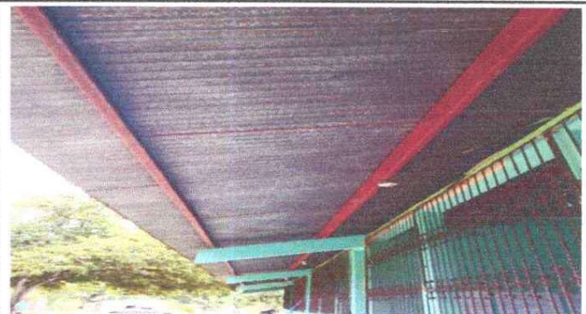
Foto 2: Mantenimiento de estructura de soporte de metal.
