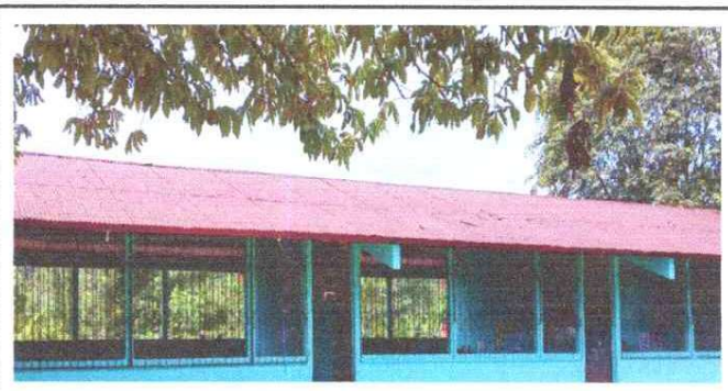
Foto 4: Sustitución de capotes de lámina para lámina troquelada Aluzinc calibre 26.
