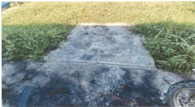
Foto 3: Reparación de Banqueta de concreto
