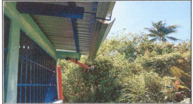
Foto 2: Sustitución de soporte o pescante de metal para canal
