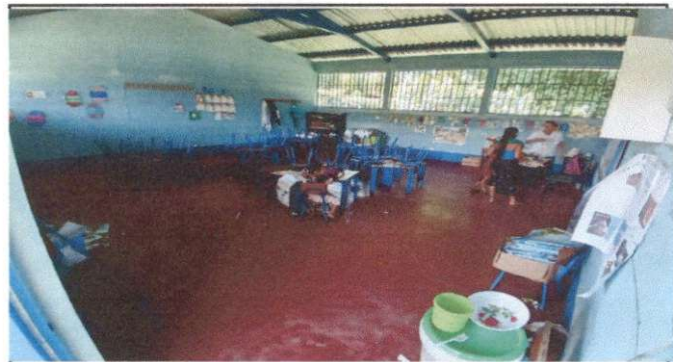
Foto 4: Reparación de piso de cemento liquido
