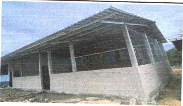
Instalación de malla galvanizada con tubo HG en la parte de enfrente y a un lado
