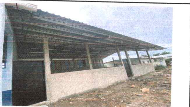
Instalación de lamina troquelada aluzinc calibre 26 y estructura portante de metal en corredor
