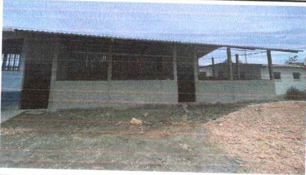
Dos puertas de metal instaladas
