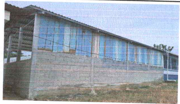
Reparación de pared con block y madera existente en la parte de atrás
