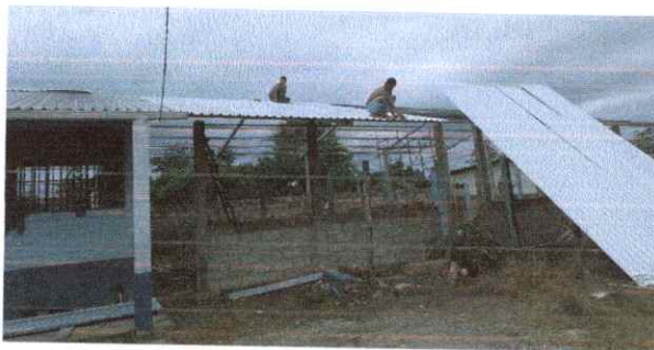
Instalación de lámina troquelada aluzinc calibre 26
