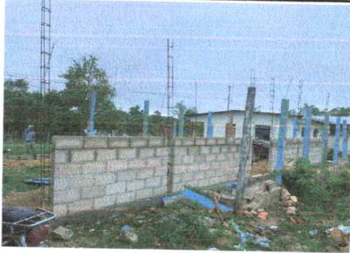
construcción de pared
