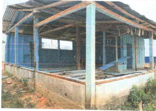
Desinstalación de madera y lamina
