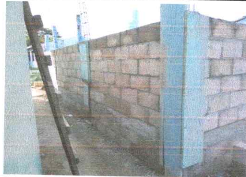
Fundición de columnas de concreto
