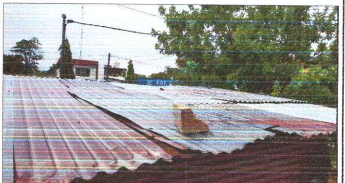
Foto 4: Instalación delaminas troquelada aluzinc
