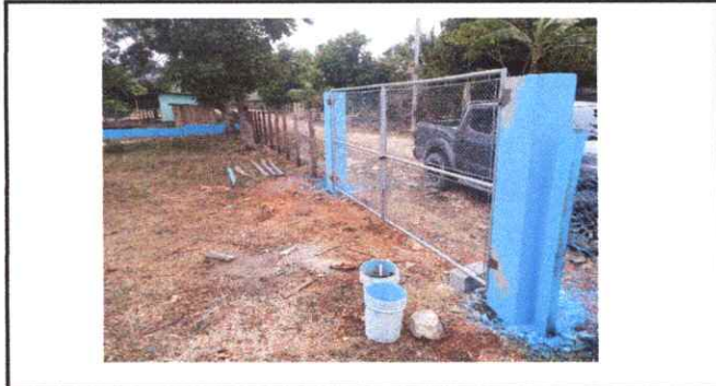
Foto 2: Portón principal y muro perimetral.
