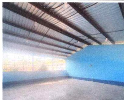
Foto 6: pintura de costaneras, mantenimiento de ventanas y susticiónn de vidrios por barroltes de hierro para una mejor ventilación.
