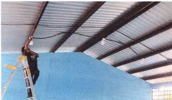
Foto 5: Reparación de instalación electricia y nueva iluminación.
