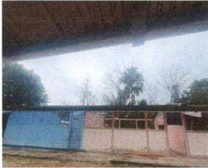
Foto1: desmontaje de cubierta de láminas, en mal estado.
