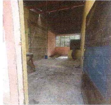
Foto 2: demolición de pared, de bodega, para habilitar una cocina adecuada para preparar alimentos.
