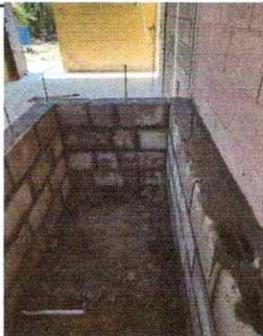
Foto 5: Elaboración de pila de concreto.
