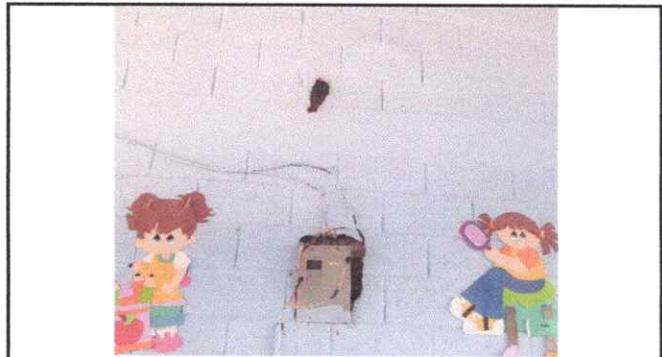
Foto 4: Caja de Flipones despegada, donde animales anidan, toda la instalación eléctrica está mala, ninguna lámpara funciona. No hay iluminación. (afecta para los niños en días nublados.)
