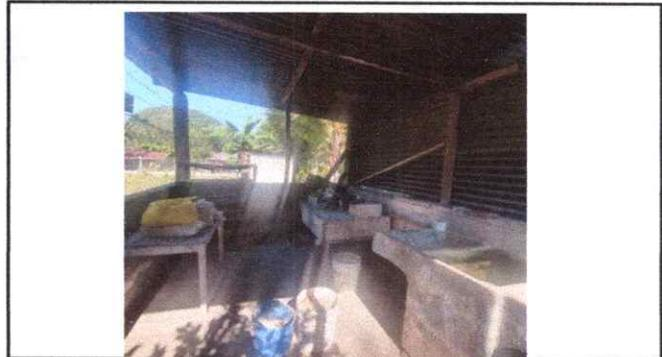
Foto 2: Interior de cocina, Pila con fugas, ornilla a punto de desmoronarse, estante podrido.
