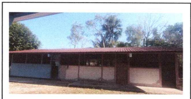
Foto 6: El techo ya necesita cambio, las láminas ya no protegen del calor y además tiene goteras. Así mismo las paredes necesitan pintura por dentro y por fuera.
