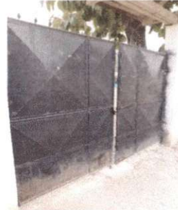
Foto 2: Sustitución de portón
