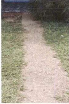
Foto 7: Reparación de plancha de cemento
