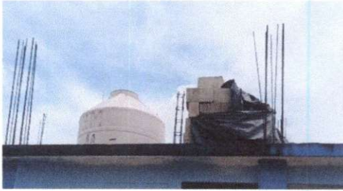
Foto 9: Sustitución de deposito de agua de 1,700 litros
