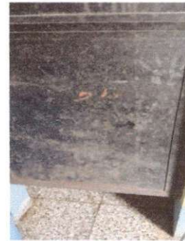
Foto 4: Mantenimiento de puertas
