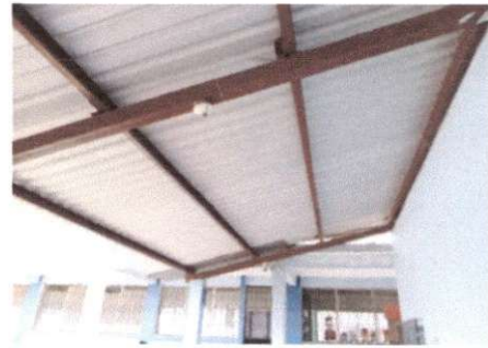
Foto 10: Sustitución de focos ahorradores
