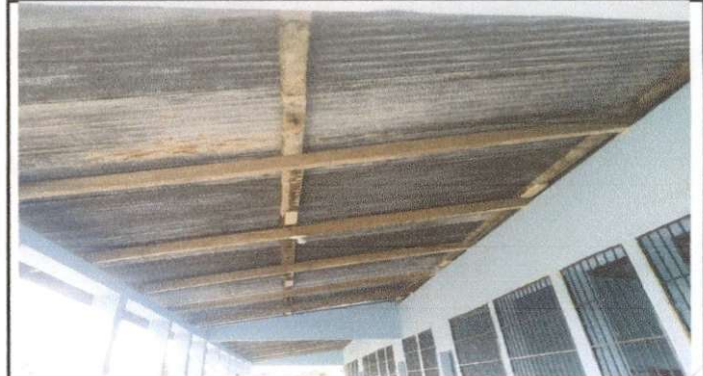
Foto 2: SUSTITUCION DE ESTRUCTURA PORTANTE DE MADERA POR METAL ✓
