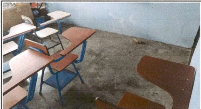
Foto 3: SUSTITUCION DE PISO DE CEMENTO LIQUIDO ✓
