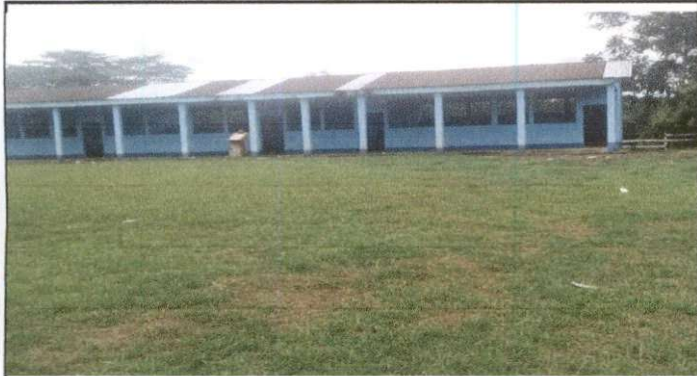
Foto 1: SUSTITUCION DE LAMINA POR LAMINA TROQUELADA ✓
