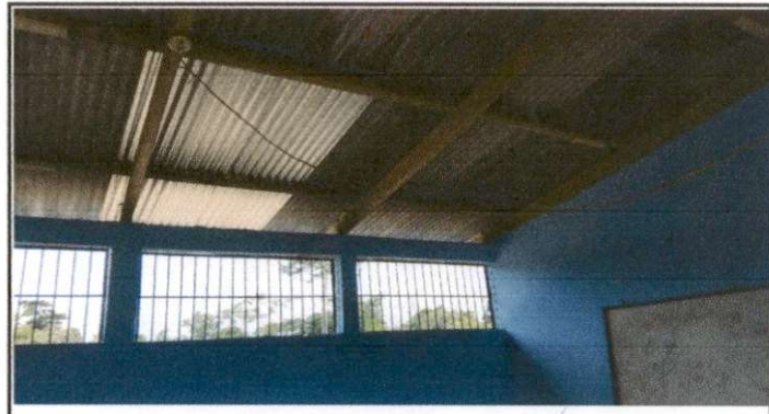
Foto 4: REPACION DE CABLEADO ELECTRICO ✓
