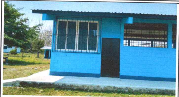
Foto 2: Instalacion de ventana PVC
