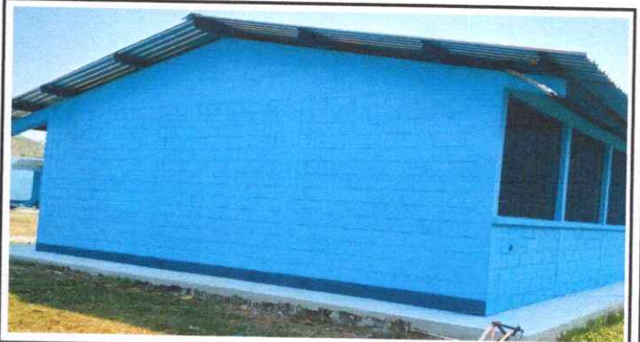
Foto 4: Cubierta de torta de concreto de corredor
