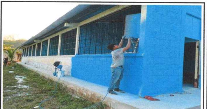
Foto: 4 Aplicación de la Pintura en la Pared
