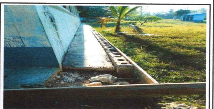
Foto: 6 Aplicación de Torta de Cemento a Banqueta
