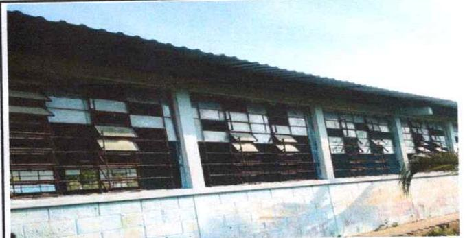
Foto: 6 Pintura Deteriorada
